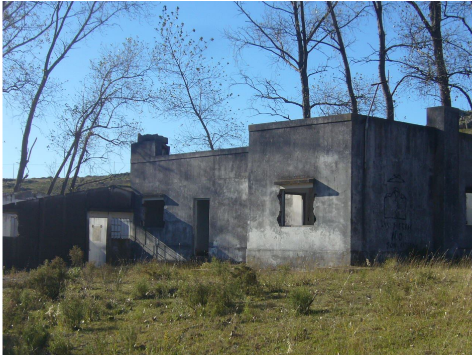
Figura 8. Restos de área edificada de la cantera Interlen.
